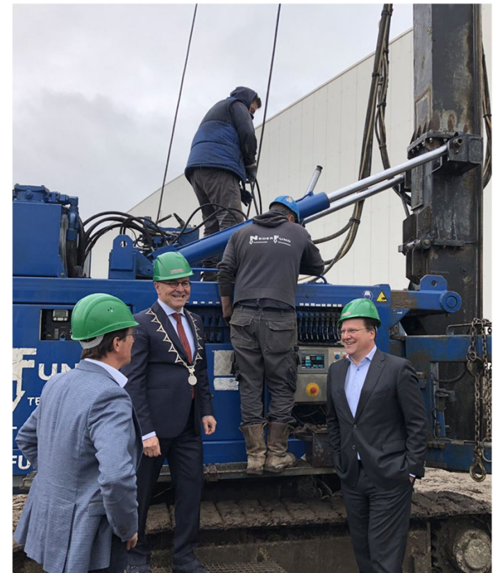
Eerste paal nieuw vers-distributiecentrum Veghel
