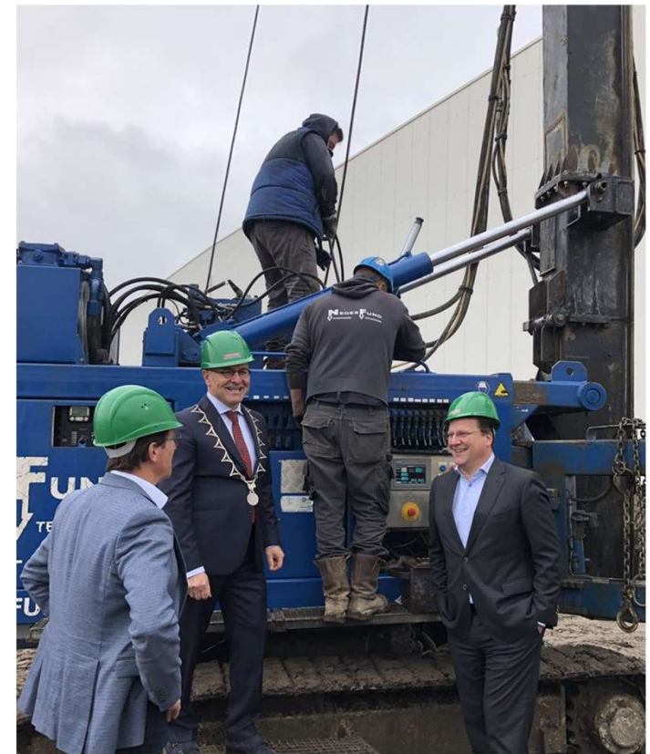
Eerste paal nieuw vers-distributiecentrum Veghel
